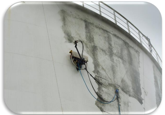
Højtryksspuling af tanksvøb. Tank Ø 29 x 22 meter høj.
