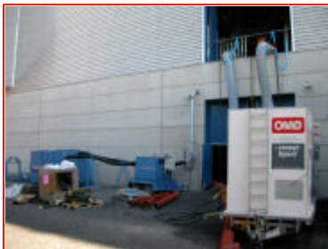
OMØ-Sugeren anvendes til ventilering af kedel å Odense Kraft- Varmeværk under sandblæsning
