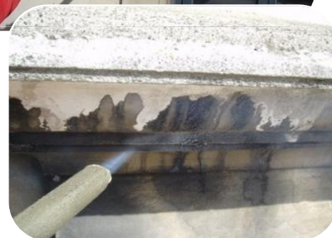
Tørisblæsning efterlader ingen rensmidler på de rensede bygningsdele.
