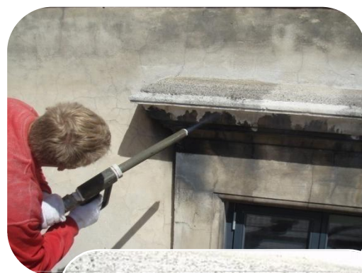
Tørisblæsning af puds og gesimsbånd på Rosendalsgade 1, Kbh..
