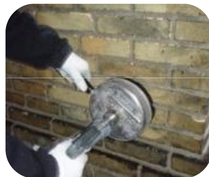
Afrensning af skorstenpiber på Tietgensgade skole, udføres uden tagbeklædning, hvorfor opgaven løses med tilbagesug så der ikke opstår vandindtrængen i bygningen
