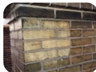
Afrensning af skorstenpiber på Tietgensgade skole, udføres uden tagbeklædning, hvorfor opgaven løses med tilbagesug så der ikke opstår vandindtrængen i bygningen
