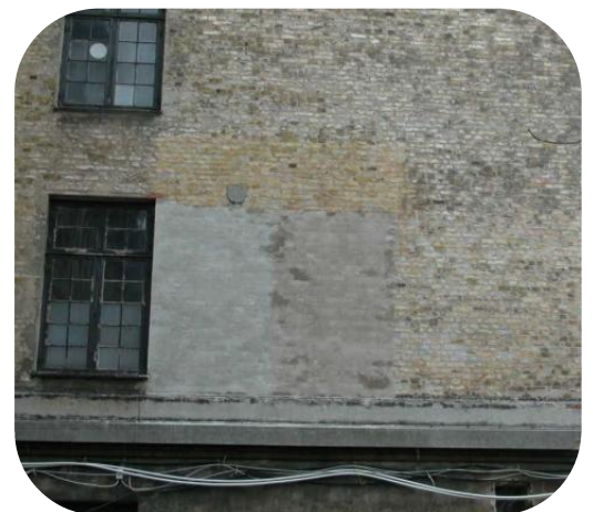
Filtsning af afrensede prøvefelter før afrensning af hele facaden.
