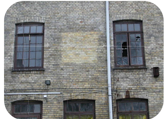
Afrensning af prøvefelter på teglsten, før afrensning til efterfølgende filts.
