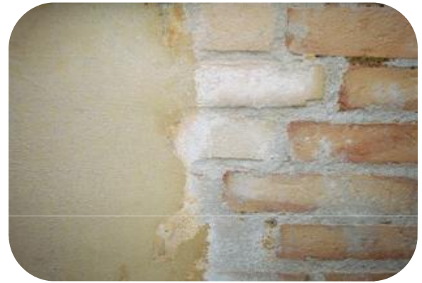
Maling og porøs puds afrenset til ny behandling
