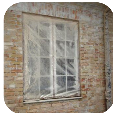
Vinduer, nedløbsrør m.m., afdækkes grundigt før sandblæsningen.
