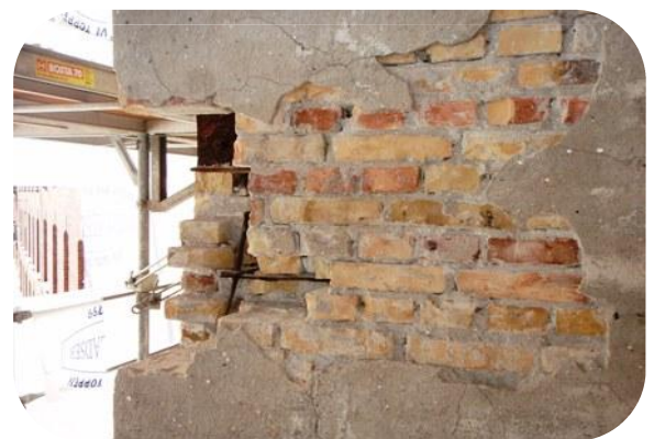
Efter sandblæsning, nedhugges murværk for at blotlægge armeringsjern og bæringer til ny overfladebehandling mod korrosion.
