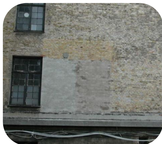
Filtsning af afrensede prøvefelter før afrensning af hele facaden.
