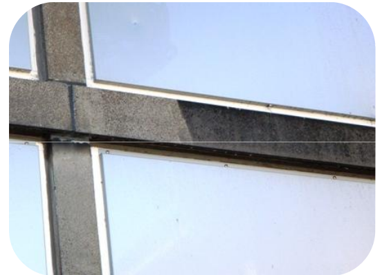
Overfladesnavs fjernes fra betonbjælke med højtryksspuling.
