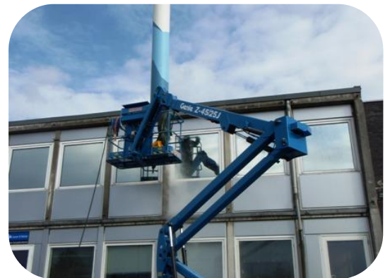
Afrensning af vinduespartier og betonbjælker foregår fra lift.
