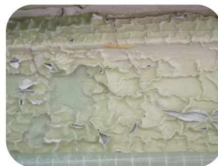
Kemiens effekt på tykt malingslag der skal fjernes fra puds ses tydeligt
